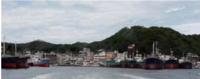
ガット船の停泊地（兵庫県家島）
