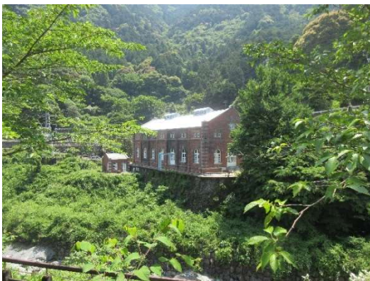
写真4 旧端出場水力発電所
