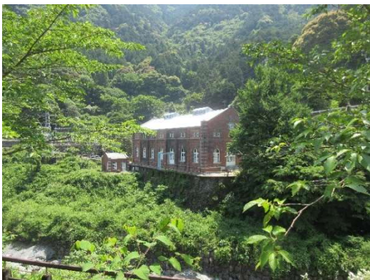
写真4 旧端出場水力発電所
