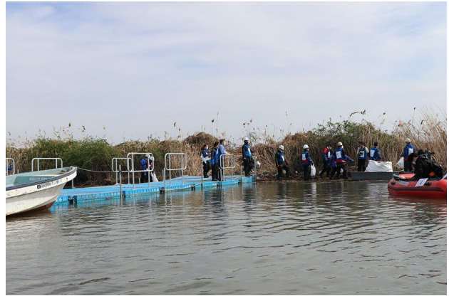
①川岸に組立式浮棧橋を設置
