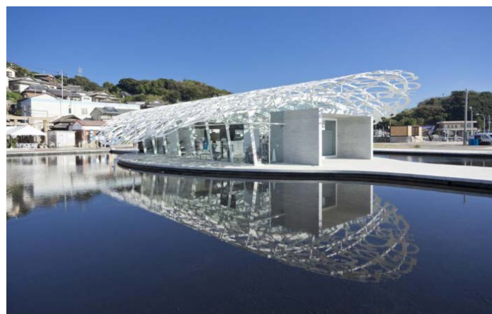
男木島の魂(2010) ジャウメ・プレサ 写真:中村脩 “タイラギガイをモチーフに、建物の屋根には 8 か国の言語が使用され 世界の多様性を表している”
