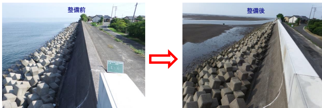
写真5 コンクリート打設による天端の嵩上げ状況
