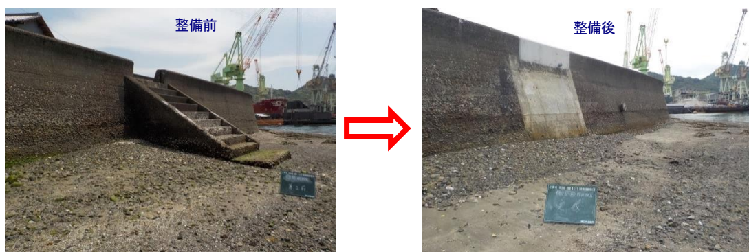
写真6 コンクリート打設による開口部の封鎖状況
