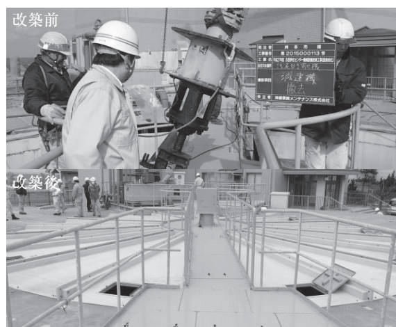
図－８ 処理場改築工事の工事監理業務
