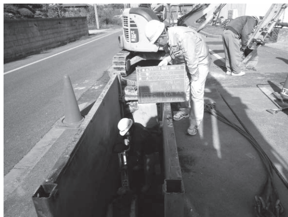
図－７ 管渠建設工事の工事監理業務
