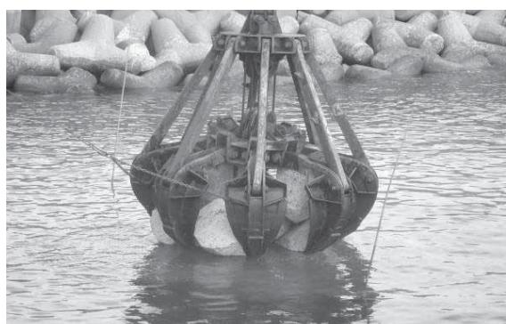
鉄鋼スラグ水和固化体<sup>注)</sup>による人工石材
