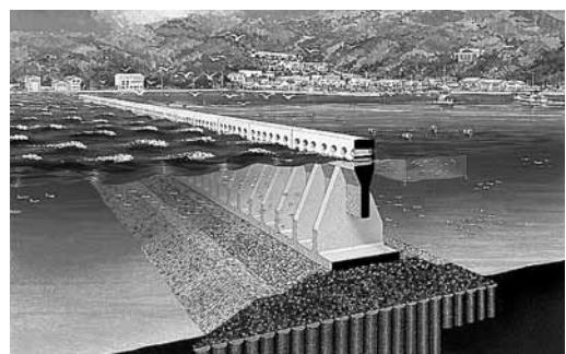
図-5 家島漁港-海水交換型防波堤
