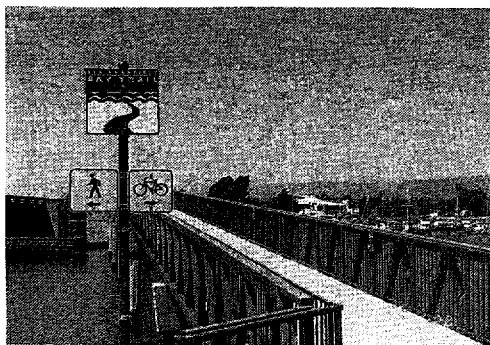
写真3 トレイルを結びつけるために設置された橋 (写真3).
