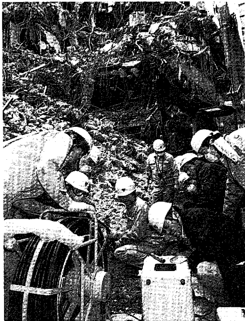
都市ガスの復旧作業 (瓦礫の中で管内カメラを利用して ガス管の被災状況を調査しているところ) (震災復興推進室課長：住友 宏)
