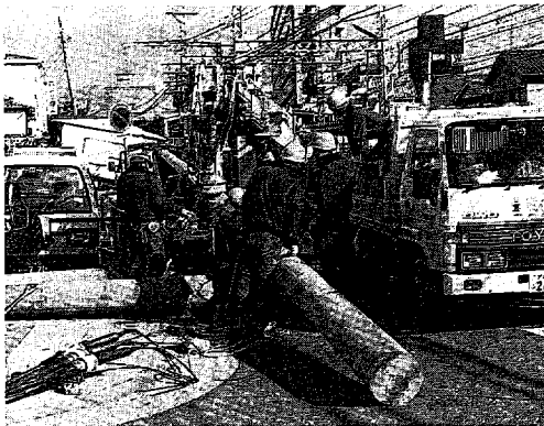
損傷した電柱を撤去し、取り替える。(1月19日・神戸市東灘区)修理が必要となった電柱は、被災地全域で約8,000本にも上った。
