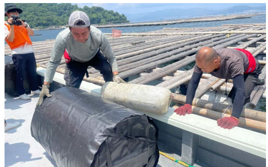
長寿命化フロートの設置
