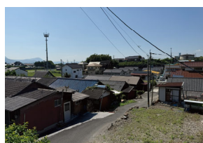
現存する炭鉱住宅
