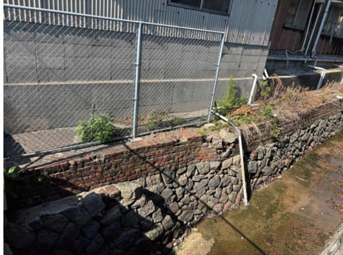
木谷の水路におけるレンガ造の護岸 撮影：門脇陽
