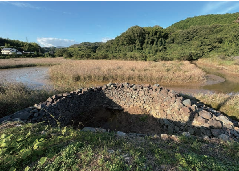
二馬手塩田跡地の樋門 撮影：成澤幹太（2025年10月6日）
