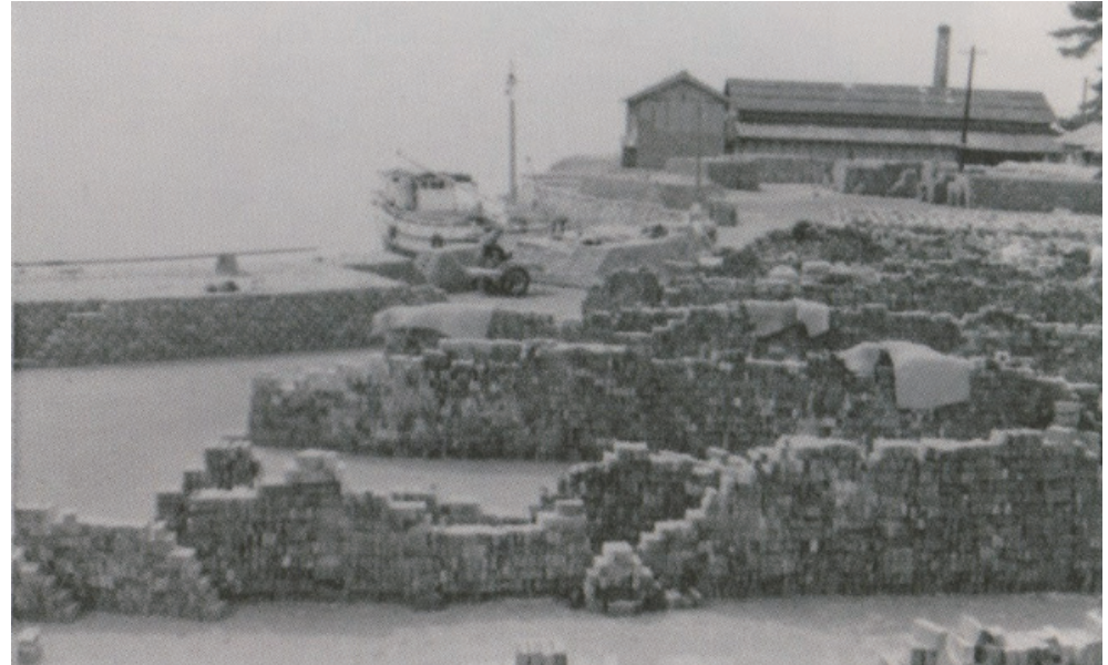
碇泊した機帆船に積み込む準備 手前には商品にならない煉瓦が山積みされている。 『木谷の歴史（改訂・増補版）』2023年、p.26
