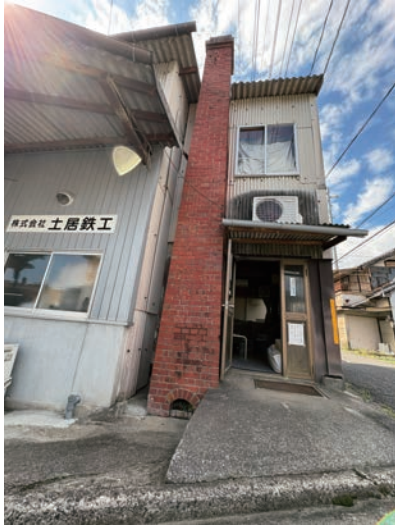
木谷の鉄工所にあるレンガ造の煙突 撮影：
