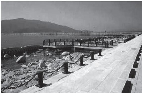
写真-2 生物共生型護岸 (五洋建設資料)
