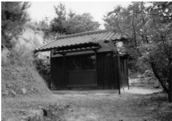
写真-2 才崎の金毘羅堂の拝殿。拝殿からは前方に海が見える。
