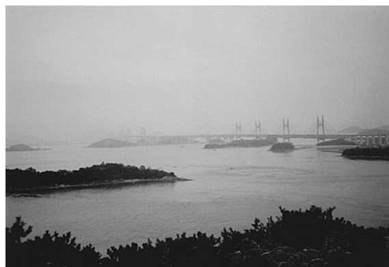
写真－４ 瀬戸大橋。多島海の風景は長大橋の風景となった。日本人の風景観ではこれも自然風景なのであろう。
